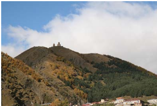
Vista de la iglesia de la Trinidad de Gergeti desde el pueblecito de Kazbegi.
